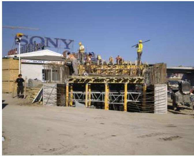
Une route en construction, Pristina, Kosovo, 6 novembre 2010 51 x 63 cm
