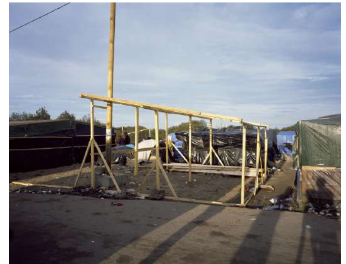
Construction d'un restaurant dans la rue commerçante du bidonville pour migrants, Calais, 1 novembre 2015. 126 x 157 cm
