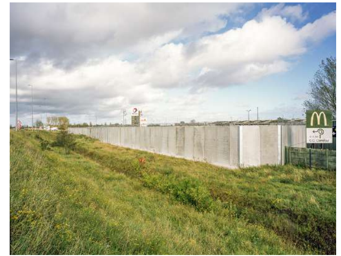
Mur anti-intrusion (T-Wall), au bord de l'autoroute A16, zone Marcel Doret, Calais, 22 octobre 2020 126 x 157 cm
